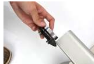
Bild 12 Schienenendstück in die Schiene einführen. Schrauben des Nutensteins dafür öffnen. Der Gummistopfen sollte stets zur Fahrtrichtung zeigen. Schraube nach Positionierung des Endstücks schließen.
